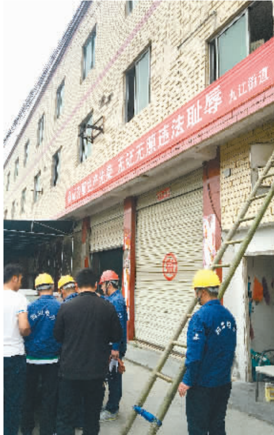
鑫宇皮鞋厂电表被拆除
