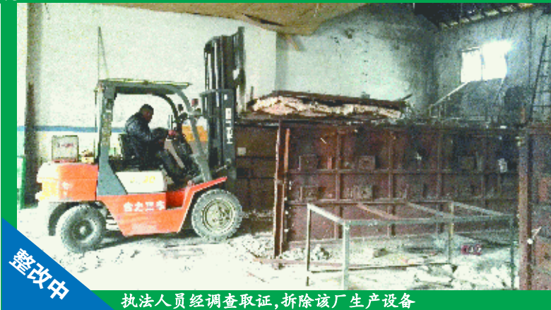
执法人员调查取证，拆除该厂生产设备
