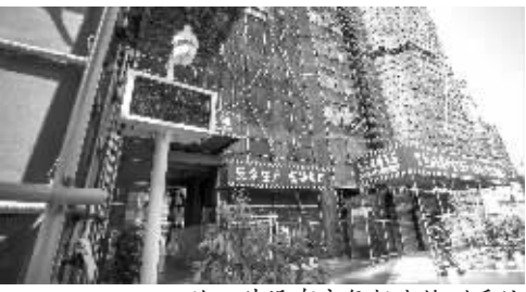
施工外设有空气扬尘检测系统
