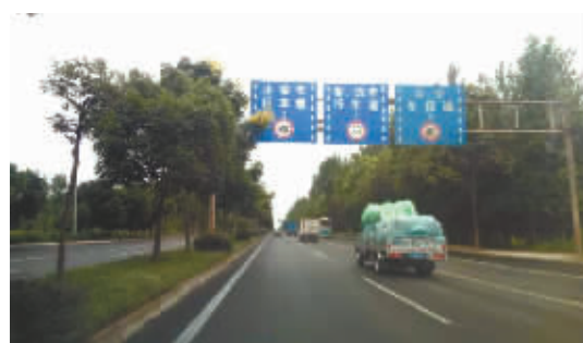
修复后的路面平坦通畅
