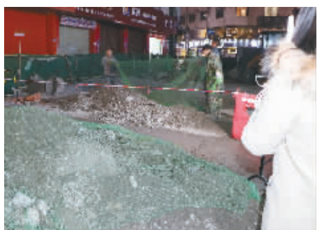
夜察中和街道半边街道路翻修工程
