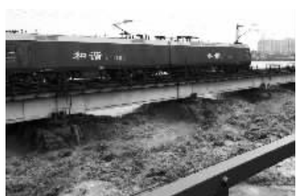
重载货物列车上桥,实施“重车压梁”
