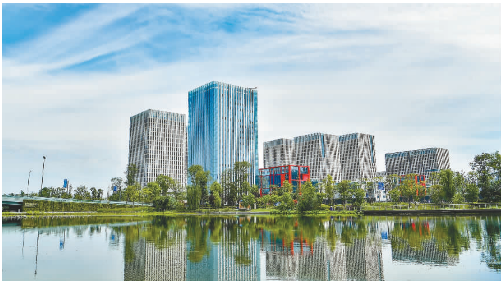
昆仑万维总部产业园所在的新川创新科技园(图据高新区)
